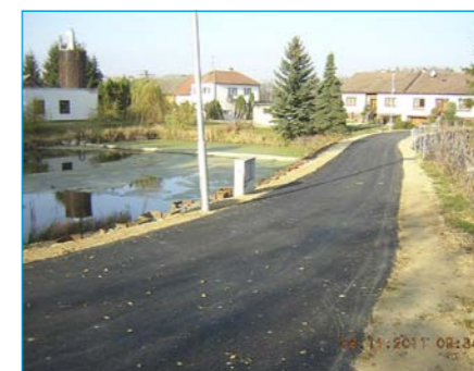
Zpevněná hráz s opravenou cestou.
